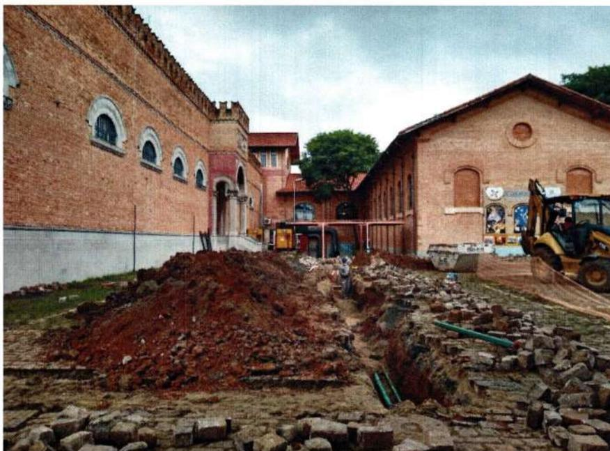
**Troca tubulações de interligação da caixa d'água com o edifício**
