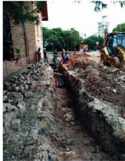
**Troca tubulações de interligação da caixa d'água com o edifício**
