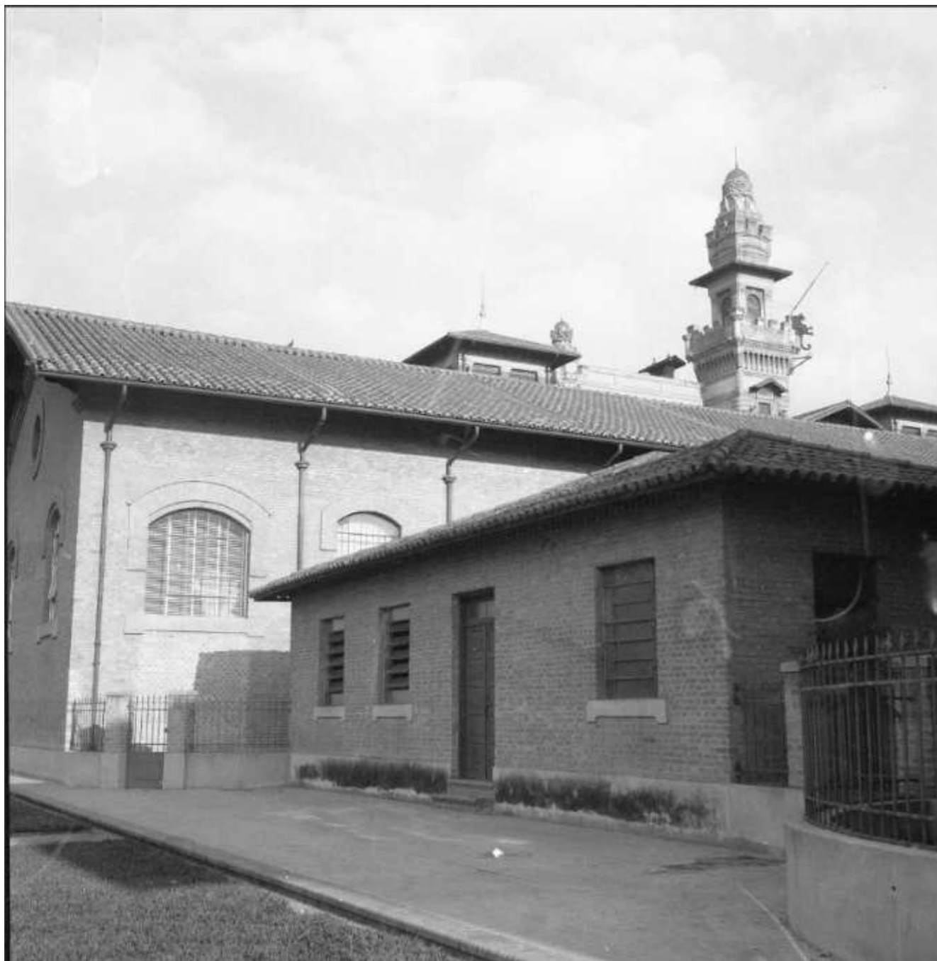
Na imagem é possível ver a edificação mais baixa, construída na década de 40 para abrigar salas administrativas no período de uso do Palácio como Assembleia Legislativa do Estado de São Paulo. A pequena edificação foi demolida no início da década de 90, quando uma grande reforma visando utilizar o Palácio como prefeitura restabeleceu a arquitetura original do edifício. (Acervo Alesp)
