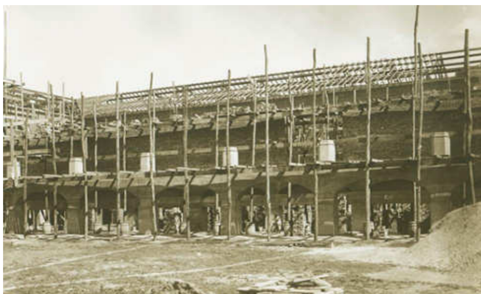
Construção dos porões e térreo do claustro do Palácio das Indústrias. (Acervo Faculdade de Arquitetura e Urbanismo FAU – USP)
