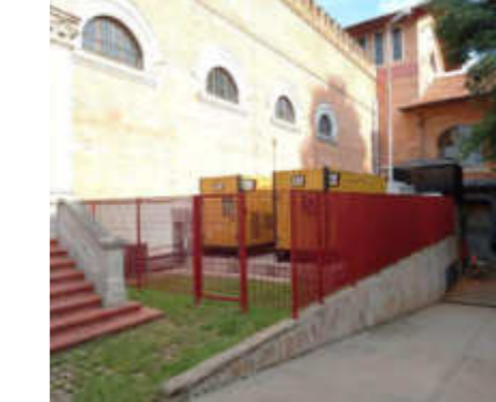
Reforma de toda infraestrutura elétrica em 2020/2021, contemplando a modernização de 68 quadros, 72 bombas de recalque, troca de todos os cabeamentos, novo QGBT, novos geradores e nova cabine primária.
