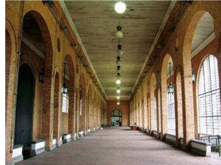
Pavilhão desocupado antes da implantação do Museu Catavento em 2007. (Acervo Museu Catavento)
