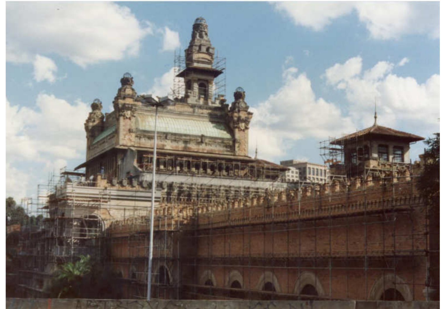
Restauração para utilização como sede da prefeitura para (Acervo Instituto Bardi / Casa de Vidro)
