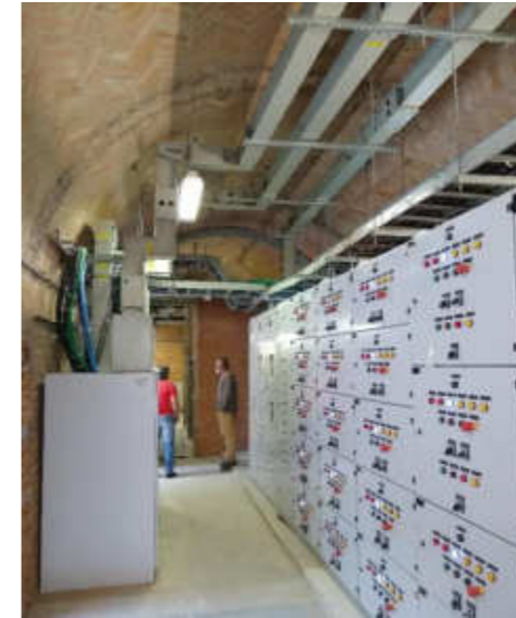
Reforma de toda infraestrutura elétrica em 2020/2021, contemplando a modernização de 68 quadros, 72 bombas de recalque, troca de todos os cabeamentos, novo QGBT, novos geradores e nova cabine primária.
