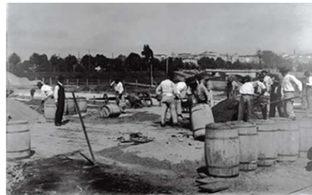
Execução das fundações do Palácio das Indústrias. (Acervo Faculdade de Arquitetura e Urbanismo FAU – USP)
