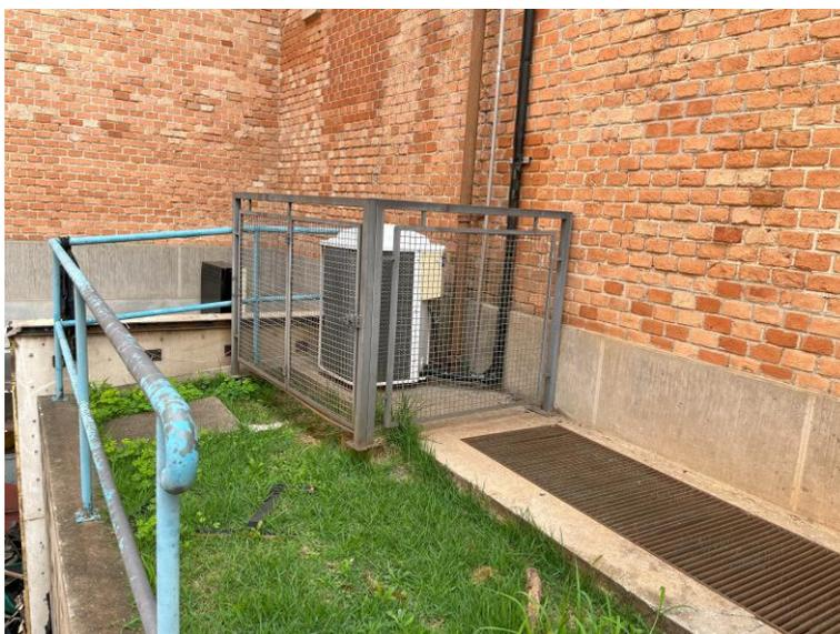
Área externa – local para instalação das condensadoras. Remoção de troncos, regularização da base e instalação de gradis de proteção. Fotos tiradas em abril/2025.
