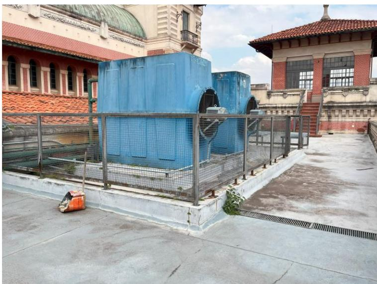
Torre de Resfriamento – remoção de gradis, muretas e base de concreto. Regularização e impermeabilização do piso. Foto tirada em abril/2025.
