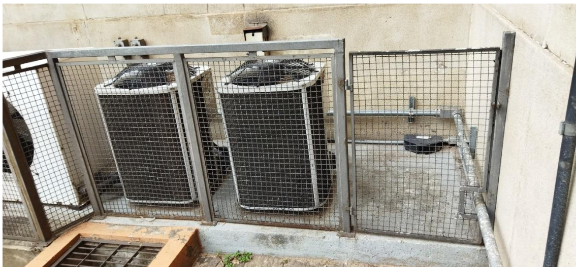
Tubulações já existentes a serem aproveitadas para instalação do sistema de ar condicionado
