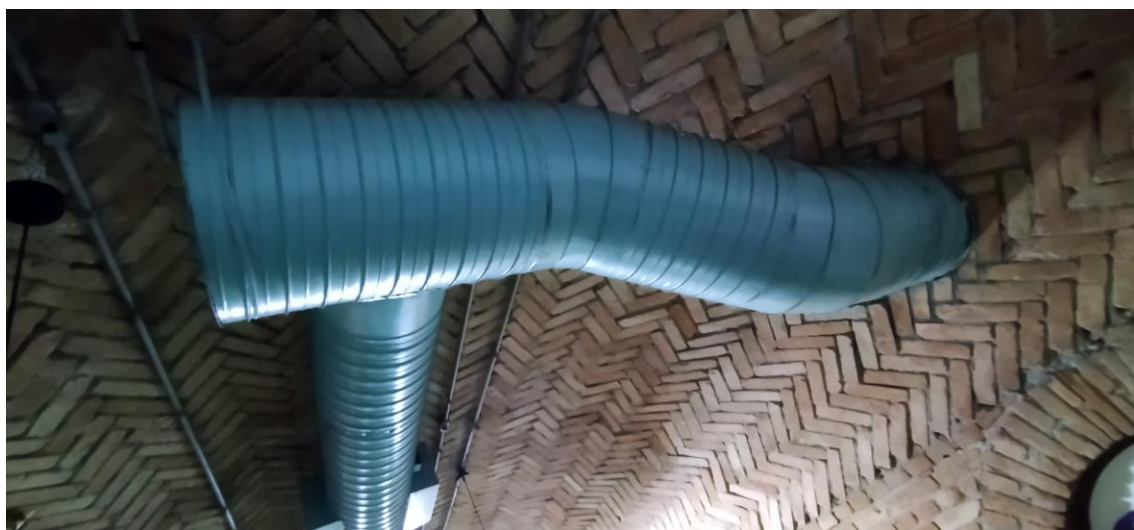
Tubulações já existentes a serem aproveitadas para instalação do sistema de ar condicionado
