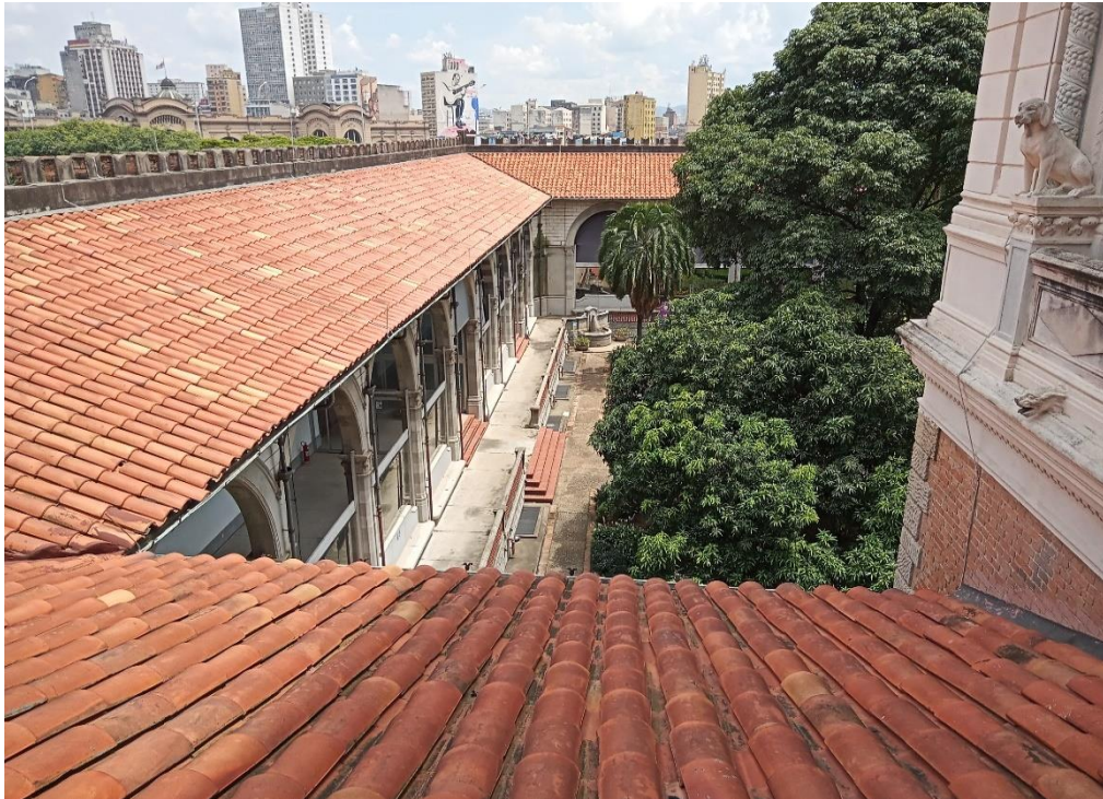
Detalhe das calhas
