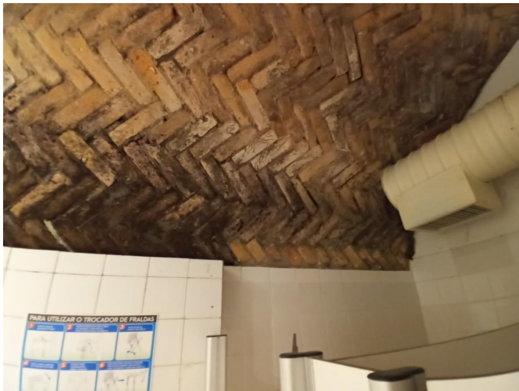
Área do banheiro
