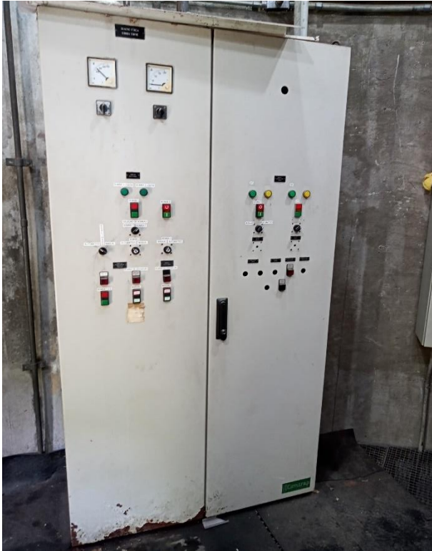
4.1 → Serviços de elétrica / automação
