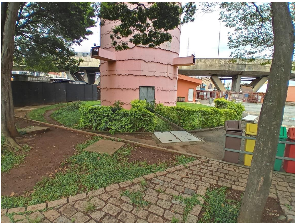
Poço de Visita do reservatório (PV)
