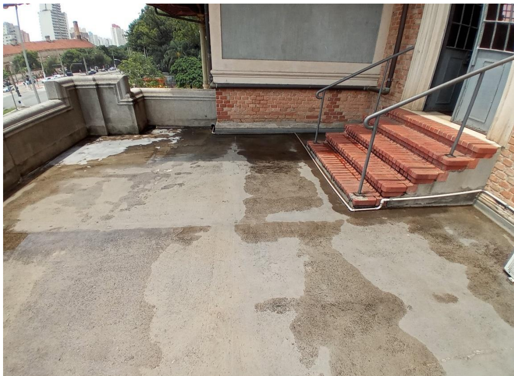
Área para impermeabilização
