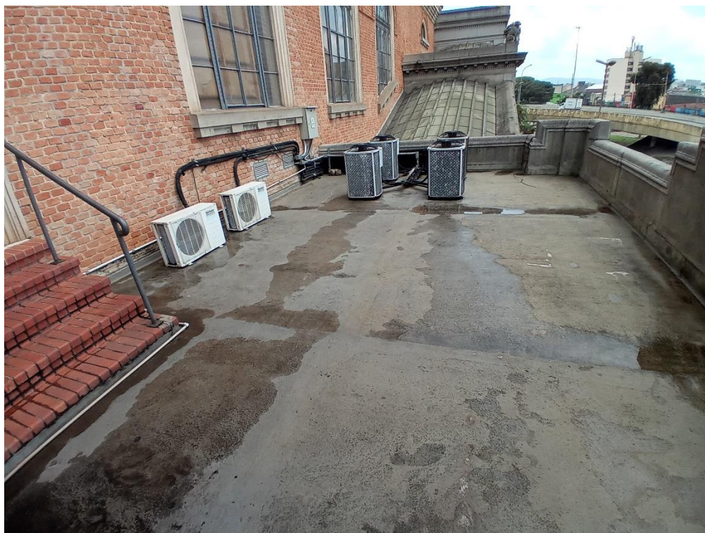
Área para impermeabilização
