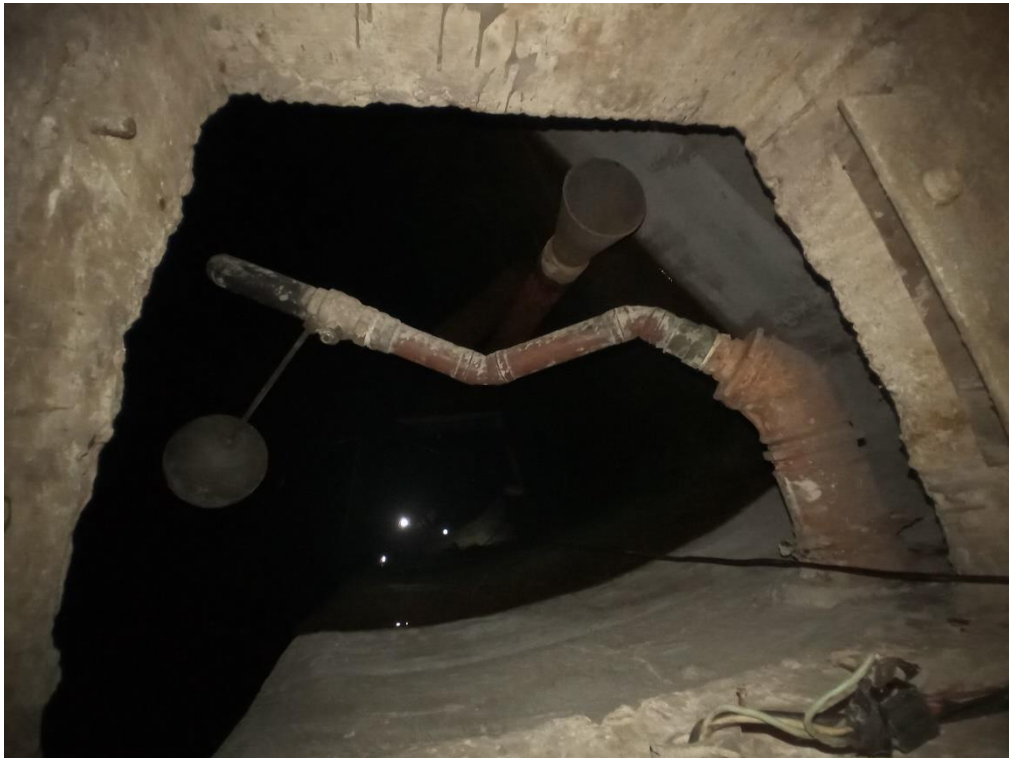
3.3 → Nível - + 12,10 / Detalhe da boia e do extravasor
