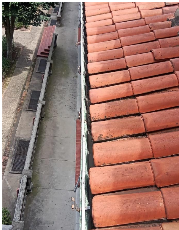
Detalhe das calhas
