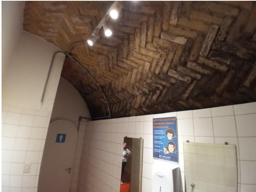
Área do banheiro
