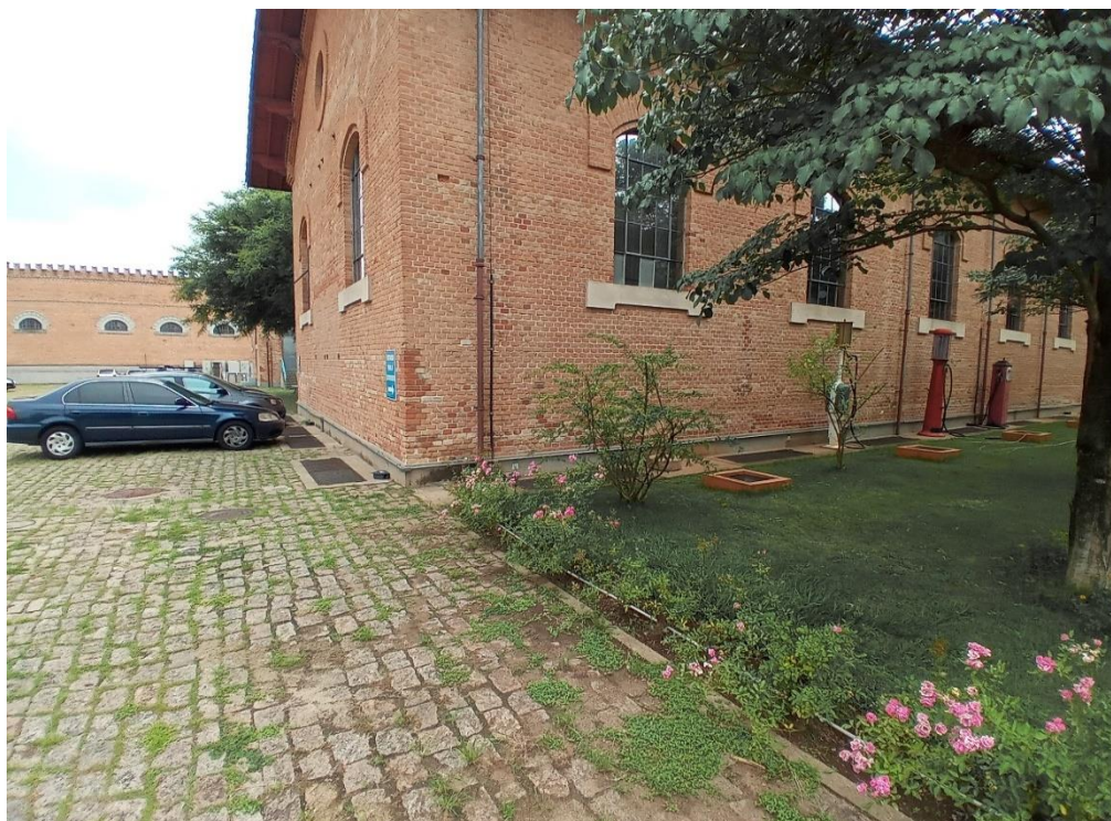
Rede do (PV) lateral - prédio administrativo
