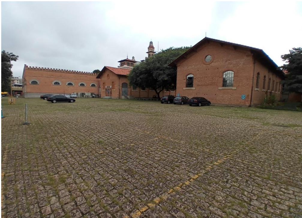
Prédio administrativo até Claustro
