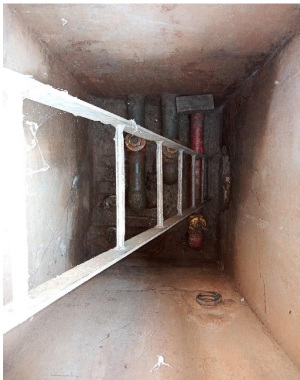
Poço de Visita (PV) prédio administrativo
