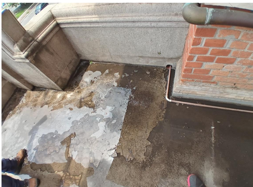
Área para impermeabilização
